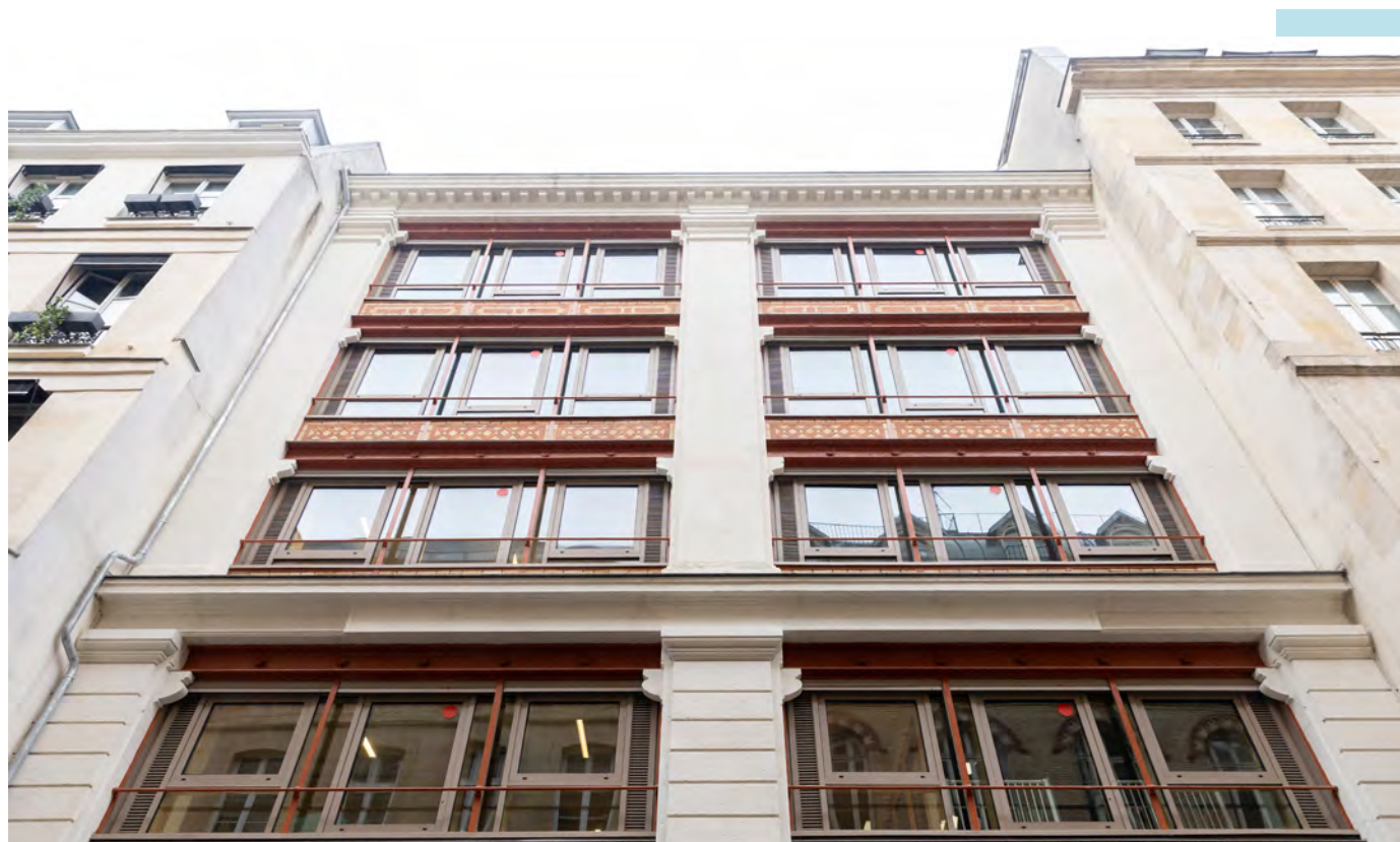
Crèche St Roch façades après rénovation @Joséphine Bruecker
