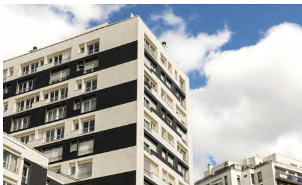
Rénovation énergétique, Lauréat du dispositif EcoRénovons @Guillaume Bontemps
