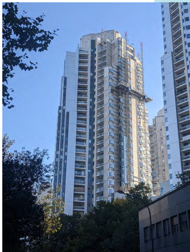
Tour Cantate, chantier de rénovation énergétique @Soliha
