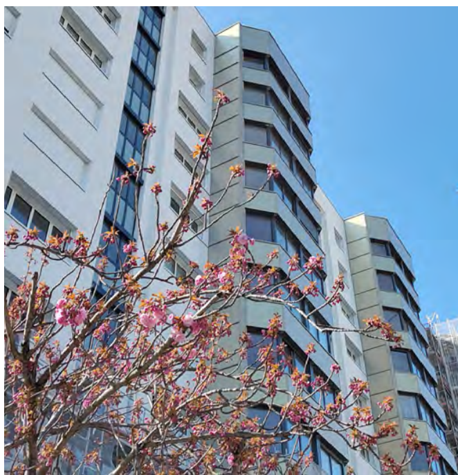
Réhabilitation de la résidence Duris, certification BBCA rénovation @Alexis Toureau, Bouygues Habitat Social
