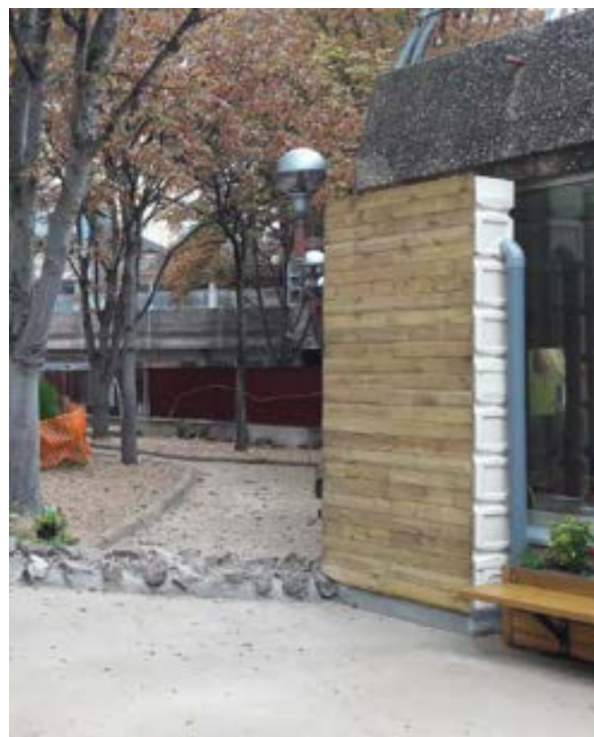
Cuve de récupération des eaux pluviales, école Émeriau (15 e )
