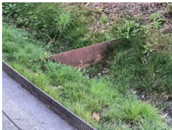
Muret de bief dans une noue végétalisée, place de Catalogne (14 e )
