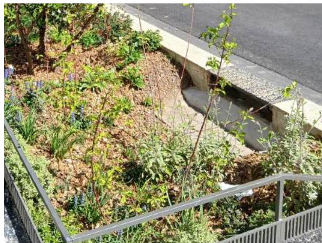
Jardin de pluie alimenté par une bouche en fonte, rue de la Croix-Nivert (15 e )
