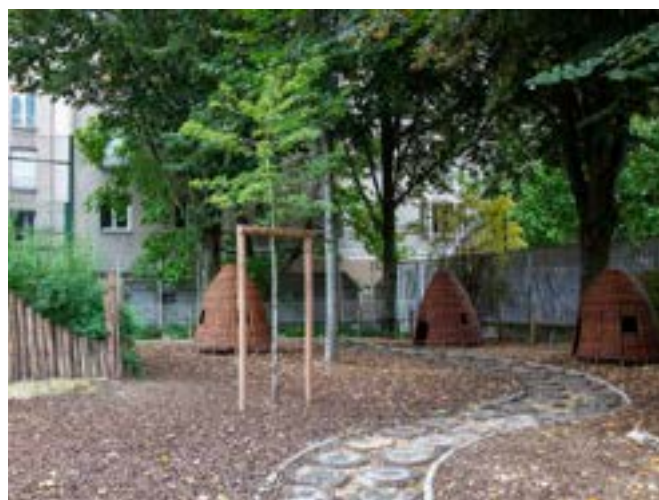
Surface perméable en copeaux de bois et pas japonais, école maternelle Tandou (19°)
