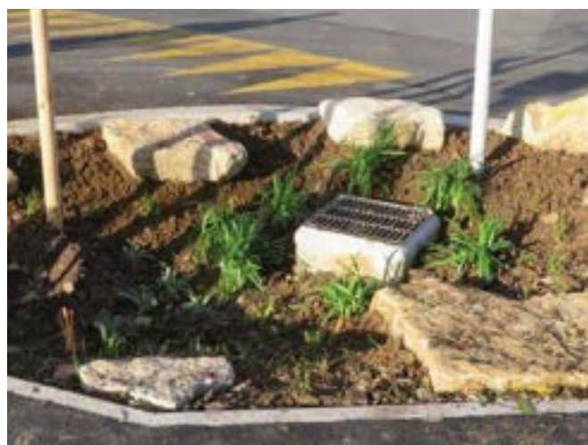
Grille de surverse surélevée dans un jardin de pluie, Gentilly (94)
