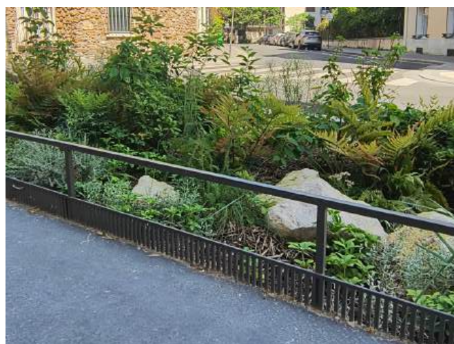
Lisse ajourée permettant le passage de l'eau vers un espace vert, rue Brillat-Savarin (13 e )
