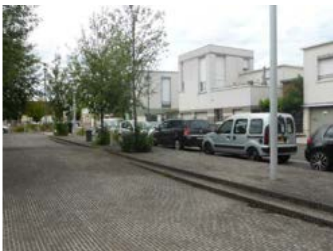
Place minérale inondable en cas de fortes pluies, écoquartier des trois rivières, Stains (93)
