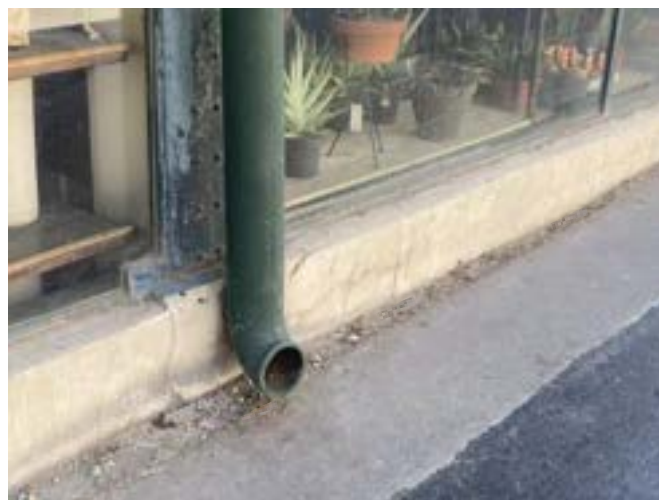
Exemples de descente d'eaux pluviales raccordée à l'intérieur d'un bâtiment (à g.) et dé raccordée (à d.)
