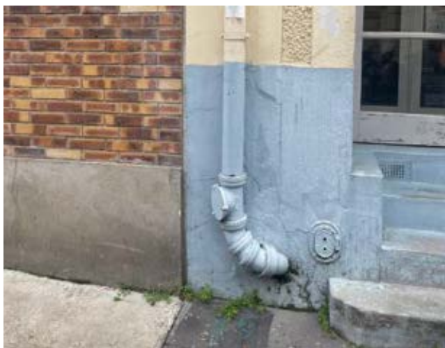
Exemples de descente d'eaux pluviales raccordée à l'intérieur d'un bâtiment (à g.) et dé raccordée (à d.)
