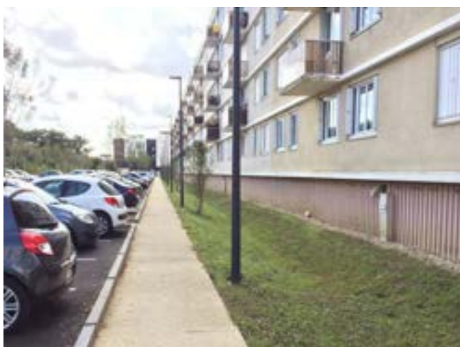
Parking inondable par mise en charge lorsque la noue est pleine, Saint-Germain-en-Laye (78)
