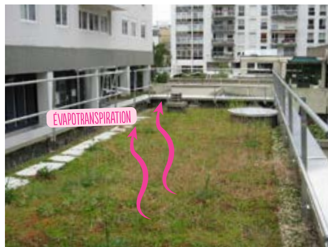
Toiture végétalisée, rue de l'Amiral Roussin (15 e )
