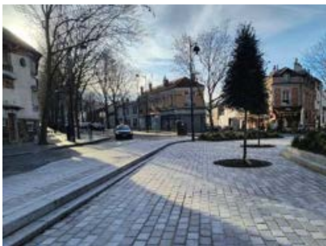
Place Rhin et Danube (19 e ), conçue pour être inondable en cas de fortes pluies
