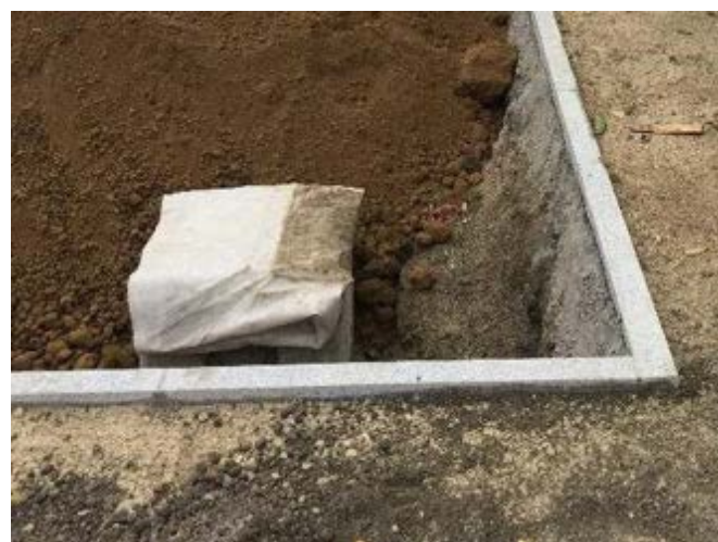
Regard à grille de surverse protégé par un géotextile dans un jardin de pluie en cours d'aménagement
