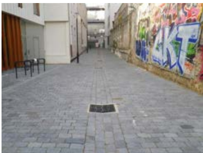
Chaussée à structure réservoir, villa Marces (11 e )
