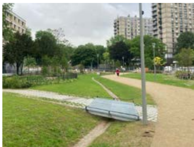
Allées en sable de Landaul et en pavés à joints engazonnés, parc Aretha-Franklin (20°)
