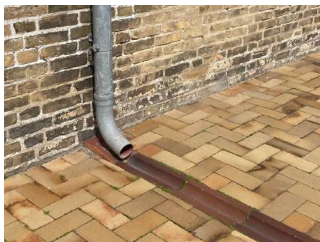
Descente d'eaux pluviales débouchant à ciel ouvert dans une rigole, Copenhague (Danemark)
