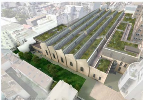
vue depuis l'arrière des ateliers
