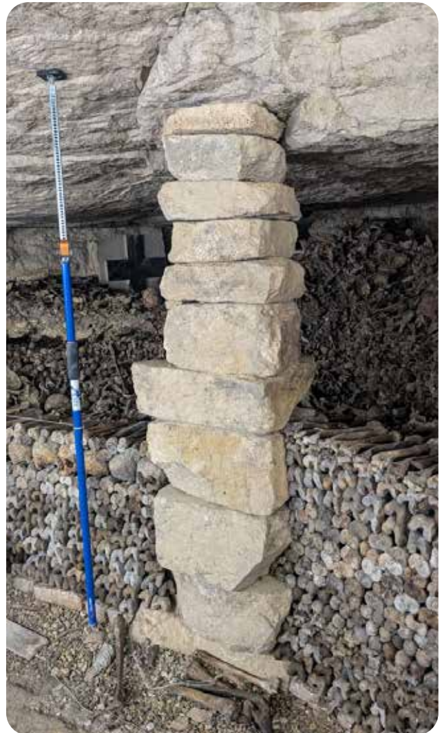
Pilier à bras réalisé
