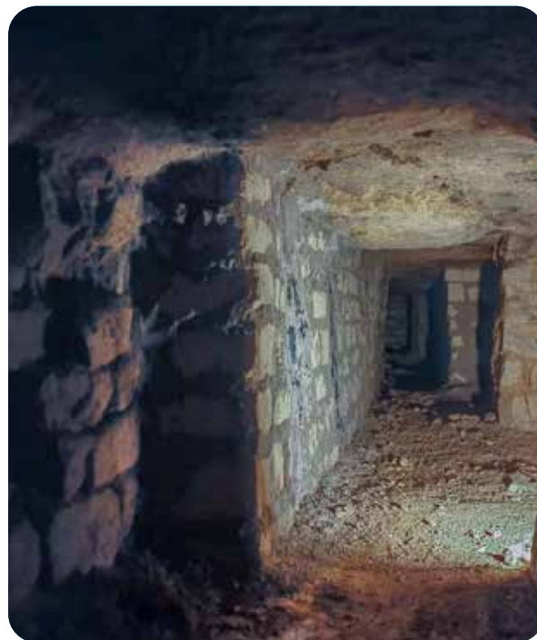
Consolidations souterraines à Chaville
