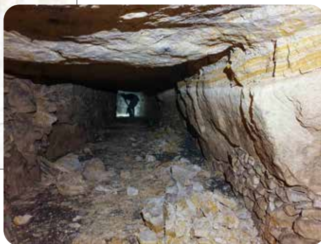
Visite d'inspection à Châtillon
