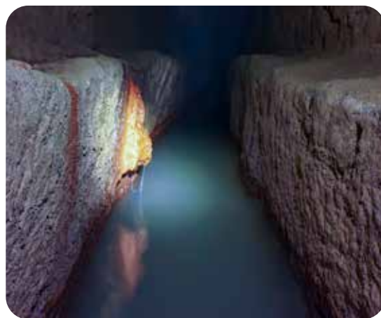
En 2025, l'IGC a procédé à des levés topographiques souterrains dans l'aqueduc du Fort et une carrière attenante
