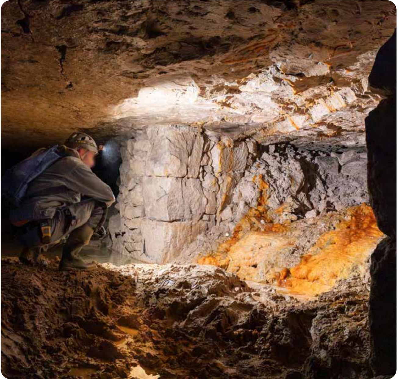
Visite d'inspection à Paris 12°
