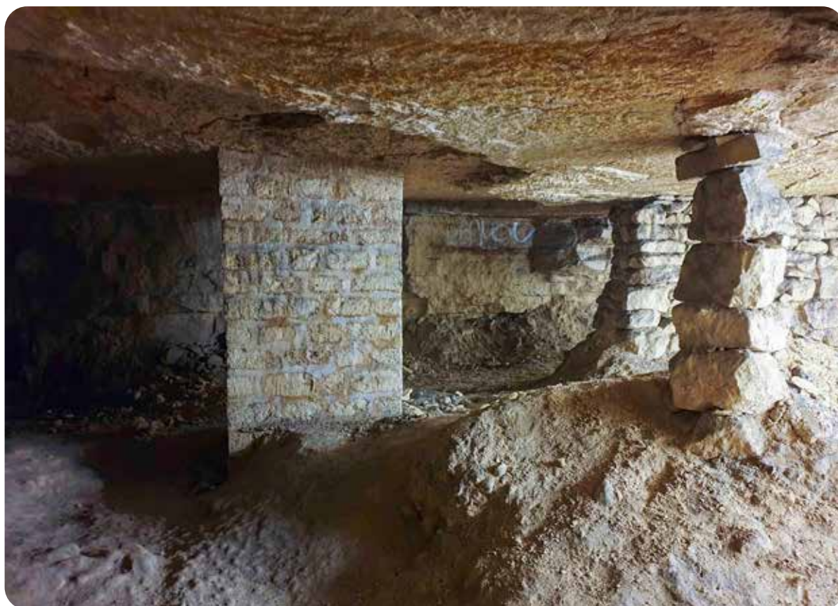
Pilier de consolidation et piliers à bras dans une carrière souterraine à Paris
