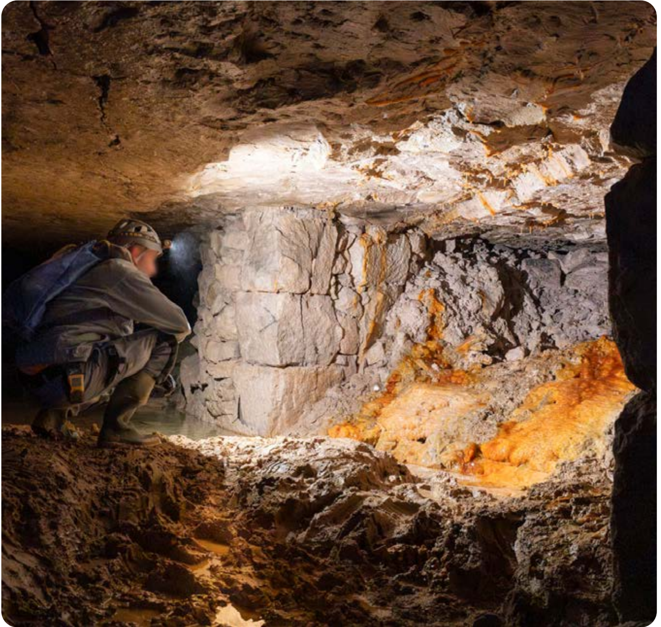
Visite d'inspection à Paris 12°
