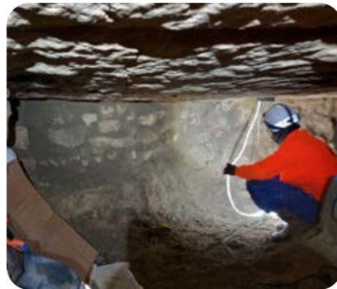
En bas : réalisation d'un mur de barrage en carrière pour contenir le coulis de comblement.
