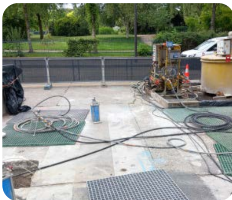
En haut : injections de coulis de comblement depuis la surface.
