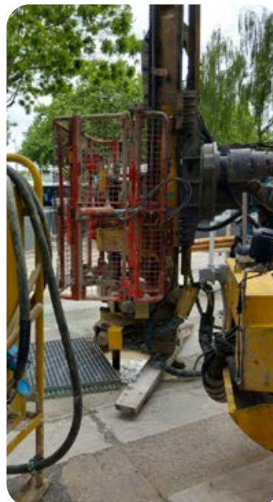
En haut : injections de coulis de comblement depuis la surface.
