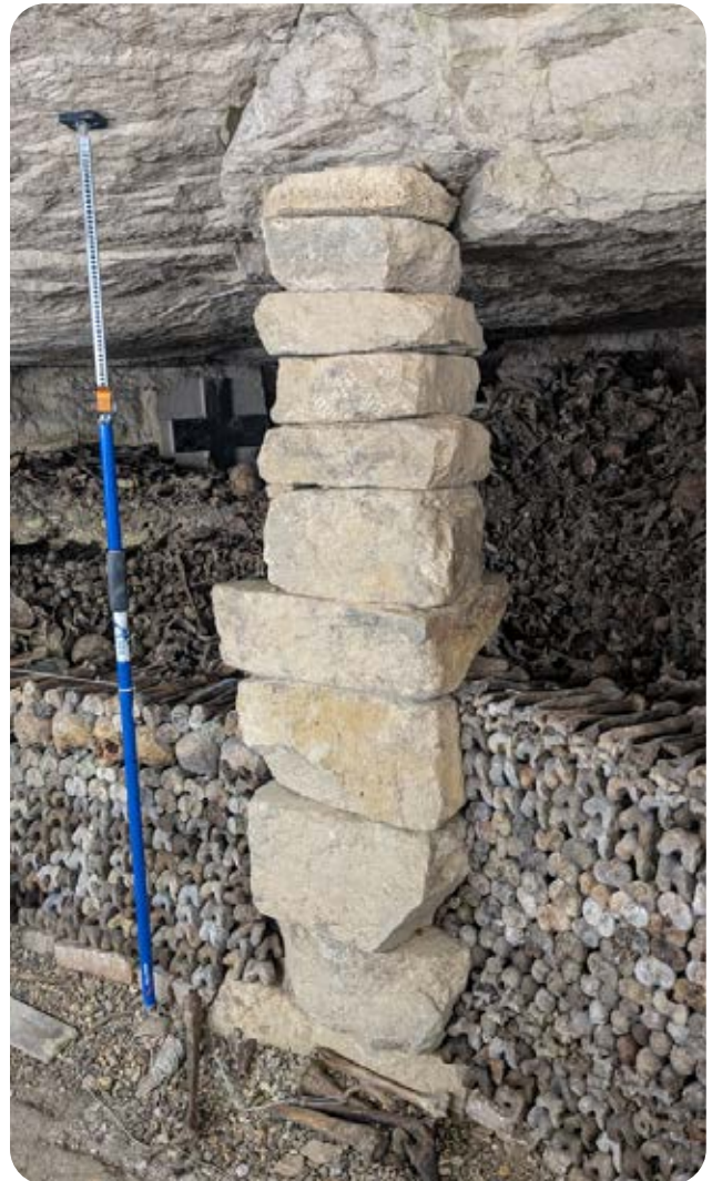
Pilier à bras réalisé
