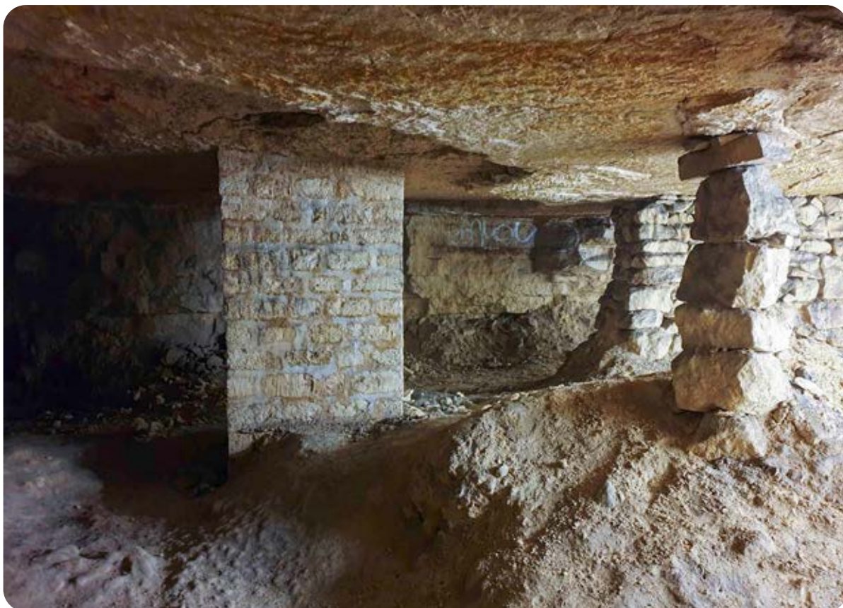
Pilier de consolidation et piliers à bras dans une carrière souterraine à Paris
