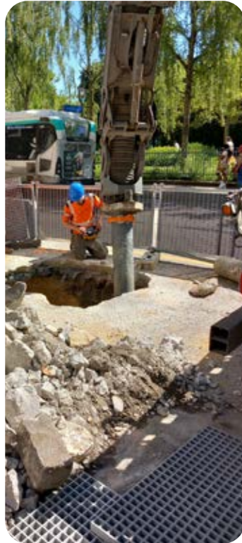
À gauche : fouilles de reconnaissance des réseaux existants (égouts, télécommunications, etc.).
