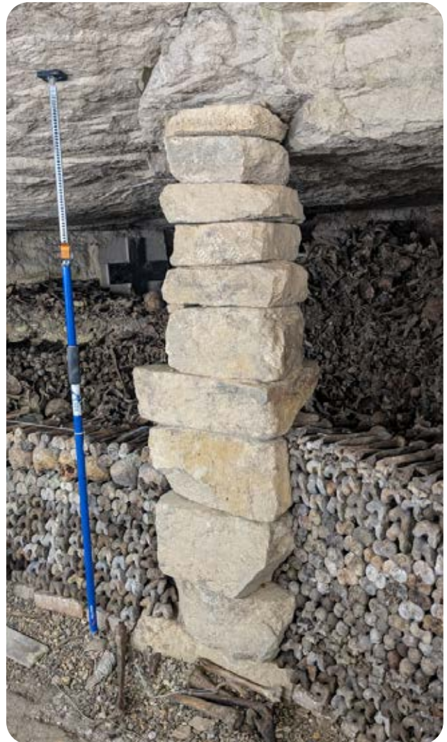
Pilier à bras réalisé
