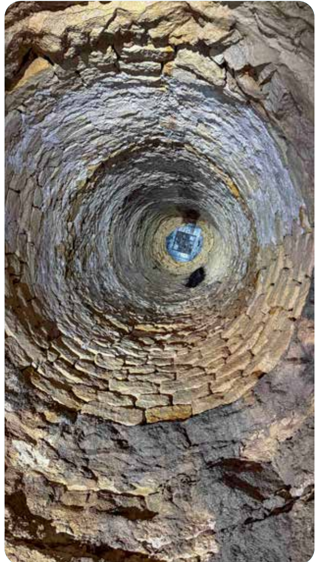
Ancien puits à Saint-Maur-des-Fossés
