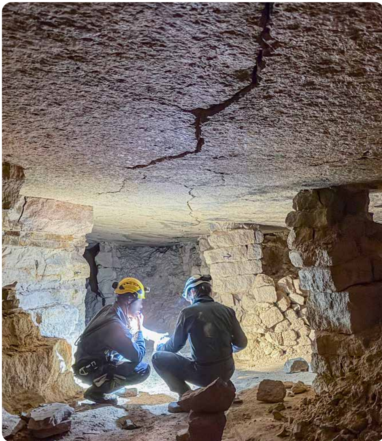
Visite d'inspection à Saint-Maur-des-Fossés
