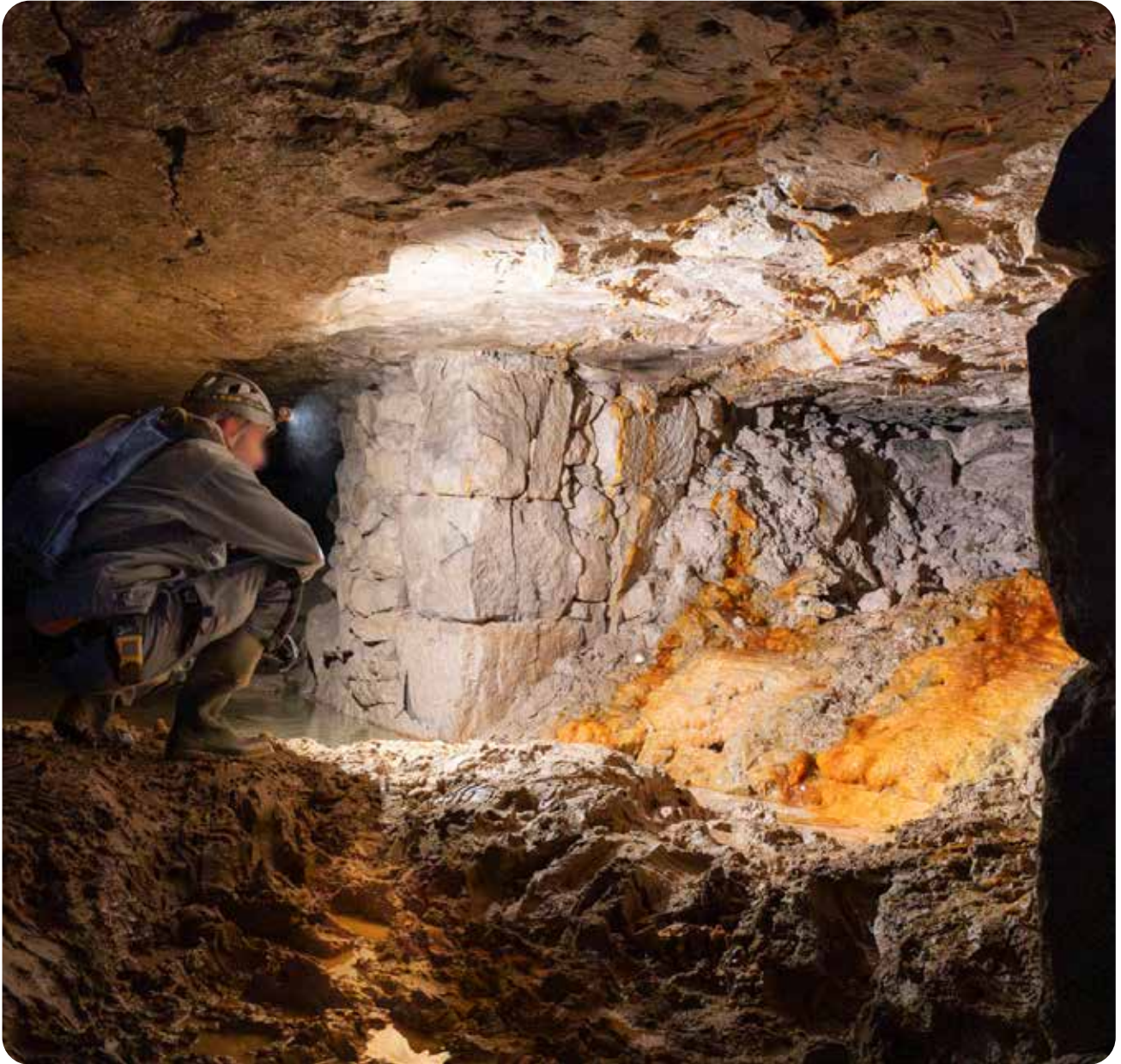
Visite d'inspection à Paris 12°
