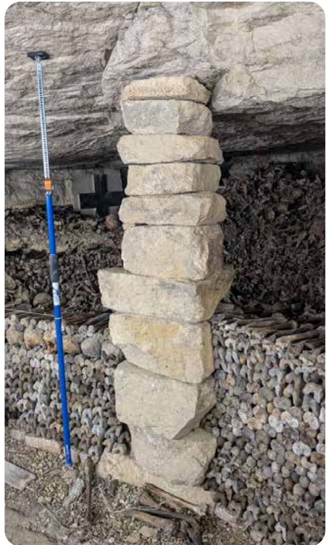
Pilier à bras réalisé
