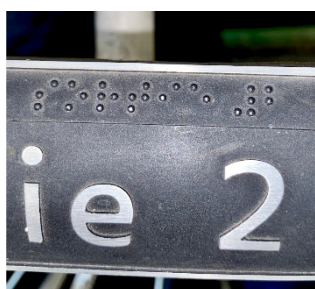
Exemple de signalétique disposé sur les rampes de la station Rue des Boulets (Paris 11 e )
