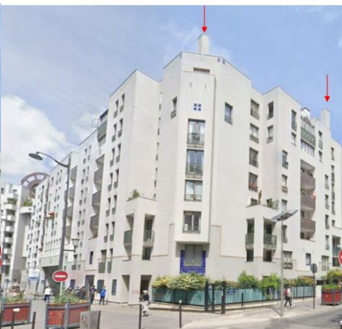
Après travaux S0-S1
