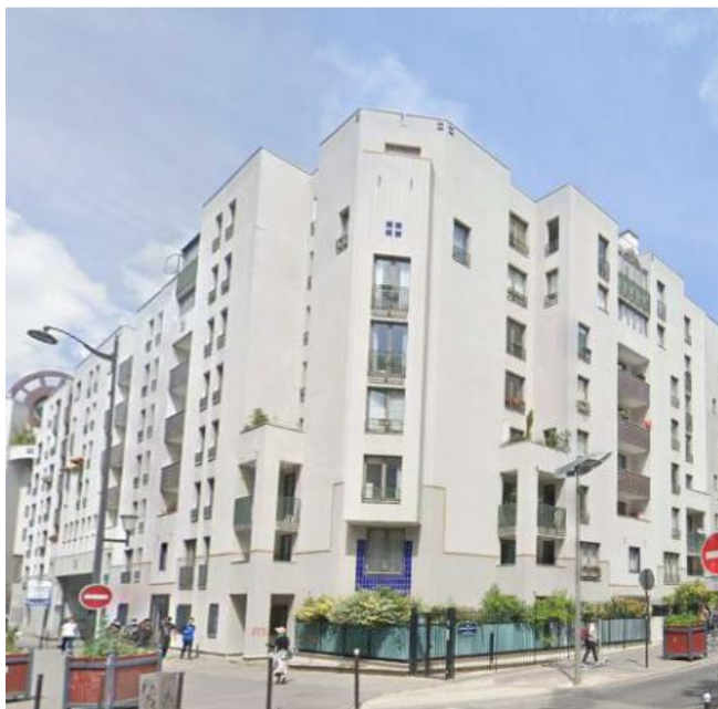
Avant travaux S0-S1
