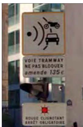
Exemple de la SV sur le mât supportant le signal R24 pour un « carrefour noir »
