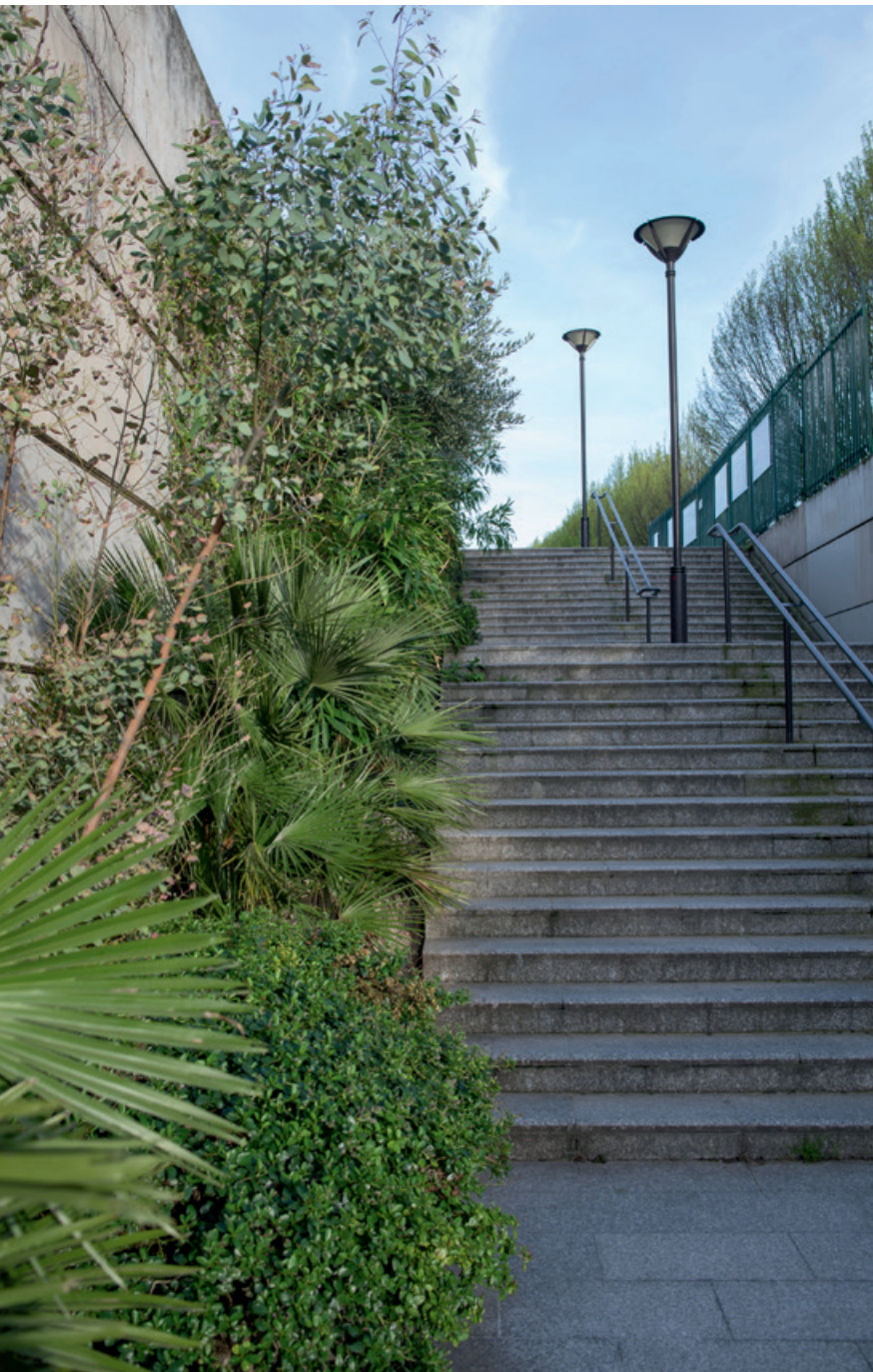
JARDIN DE REUILLY PAUL PERNIN (12 E ) escaliers donnant accès à la Coulée verte, ancienne voie ferrée qui parcourait l'est parisien pour aller jusqu'en Seine-et-Marne, devenue promenade plantée
