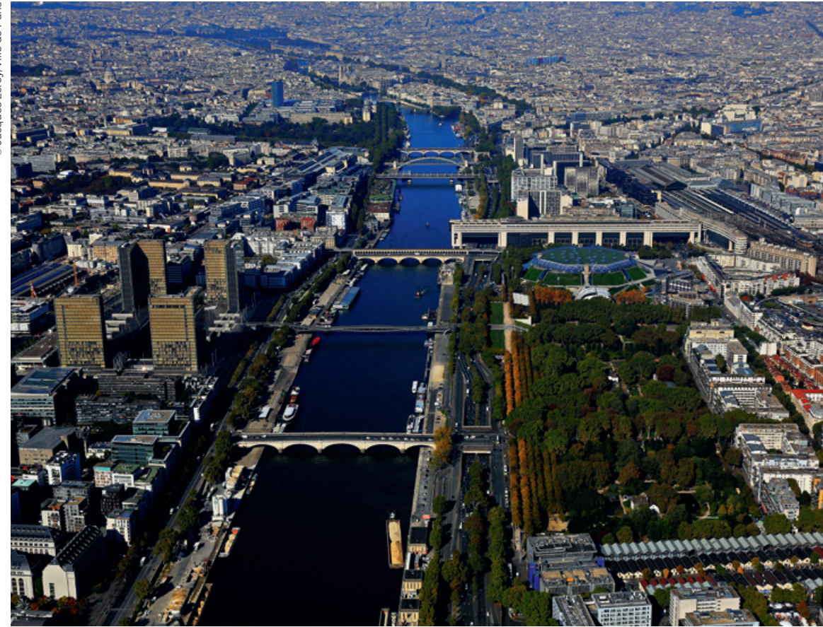
VUE AÉRIENNE DE LA SEINE ET DU VASTE PARC DE BERCY (12 E ) au tracé contemporain qui occupe l'emplacement des anciens entrepôts vinicoles, plus grand centre mondial de négoce en vin et spiritueux au XIX e
