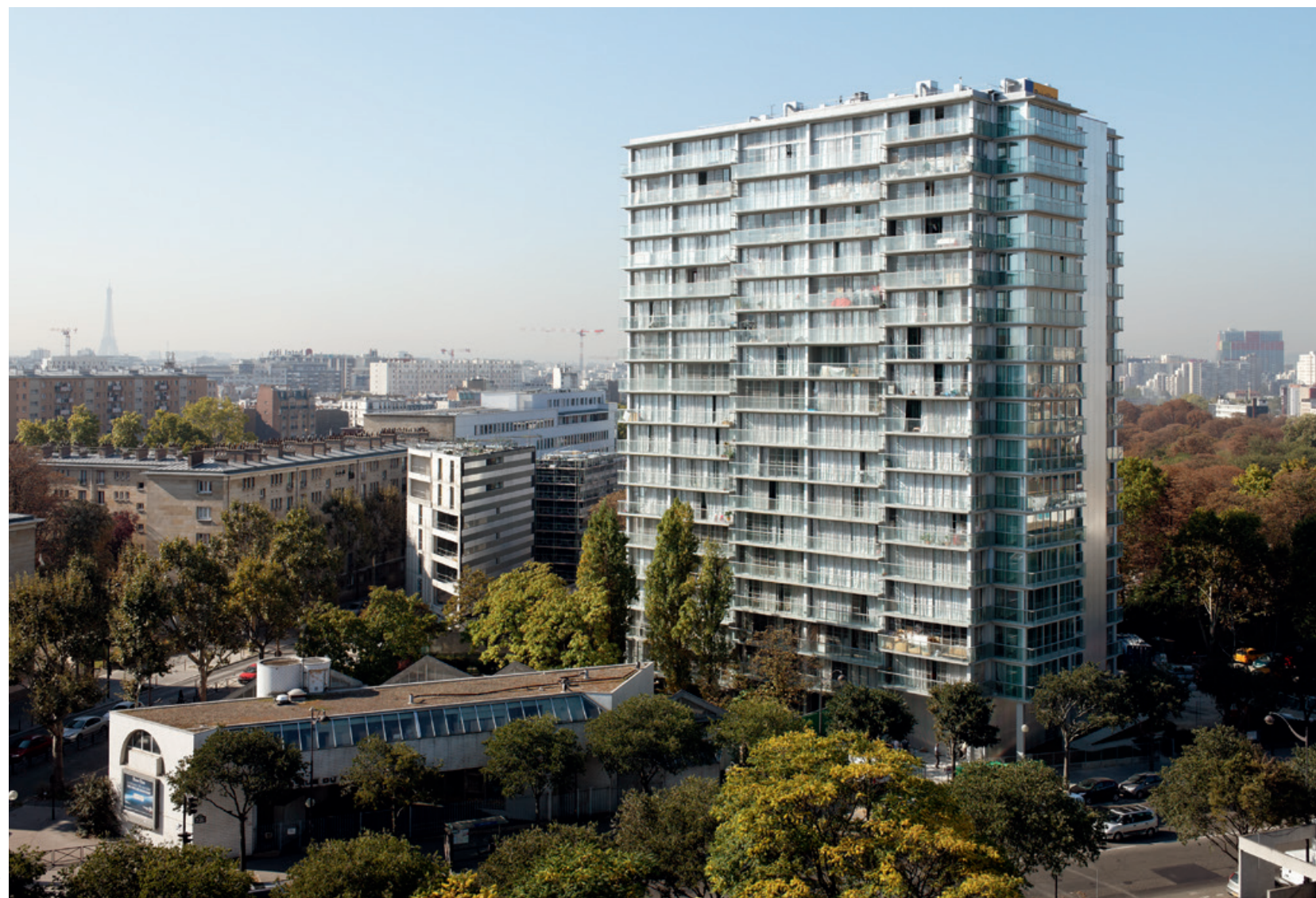
TOUR BOIS-LE-PRÊTRE (17 E ) de Raymond Lopez transformée par les architectes Frédéric Druot, Anne Lacaton et Jean-Philippe Vassal : rénovation énergétique de logements sociaux Paris Habitat par l'adjonction d'une nouvelle façade offrant aux habitants des loggias et balcons. Améliorer le construit pour améliorer la qualité de vie
