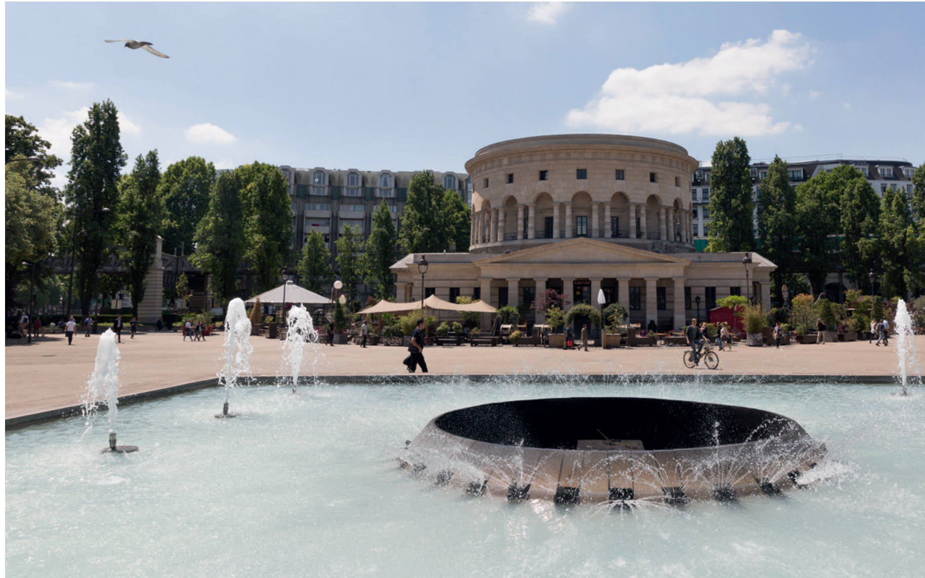
LA ROTONDE DE LA VILLETTE PLACE DE LA BATAILLE DE STALINGRAD (19 E ) ancienne barrière d'octroi du mur des fermiers généraux construite juste avant la Révolution par l'architecte Claude Nicolas Ledoux et désormais lieu de fête et restaurant
