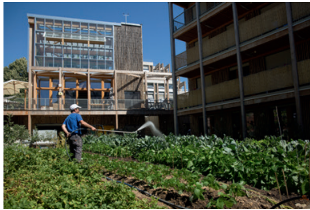
LA FERME DU RAIL (19 E ) espace d'agriculture urbaine et d'hébergement accueillant des personnes en insertion conçu par Grand Huit architectes, Clara Simay et Julien Turpin
