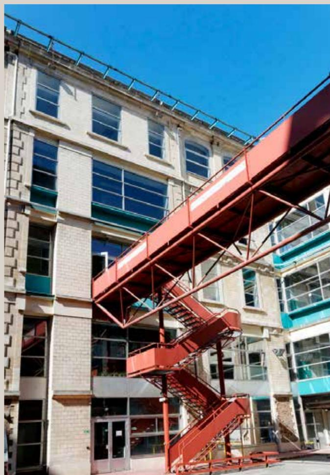
Vue des travées reconstruites sur la façade arrière du hall d'entrée et de la passerelle métallique qui réunit les deux corps de bâtiments parallèles au boulevard.
