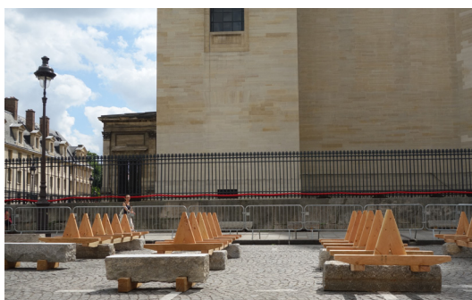
- MOBILIERS URBAINS EN CONSTRUCTION - JUILLET 2018
