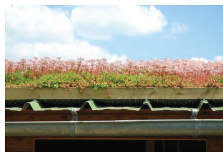
Toiture végétalisée sur le toit d'une cabane à la ferme de Paris
