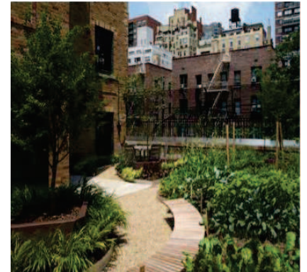
Toit végétalisé à Lenox Hill : Avant/Après
