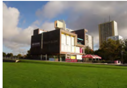
Maison du parc départemental Jean-Moulin-Les Guilands
