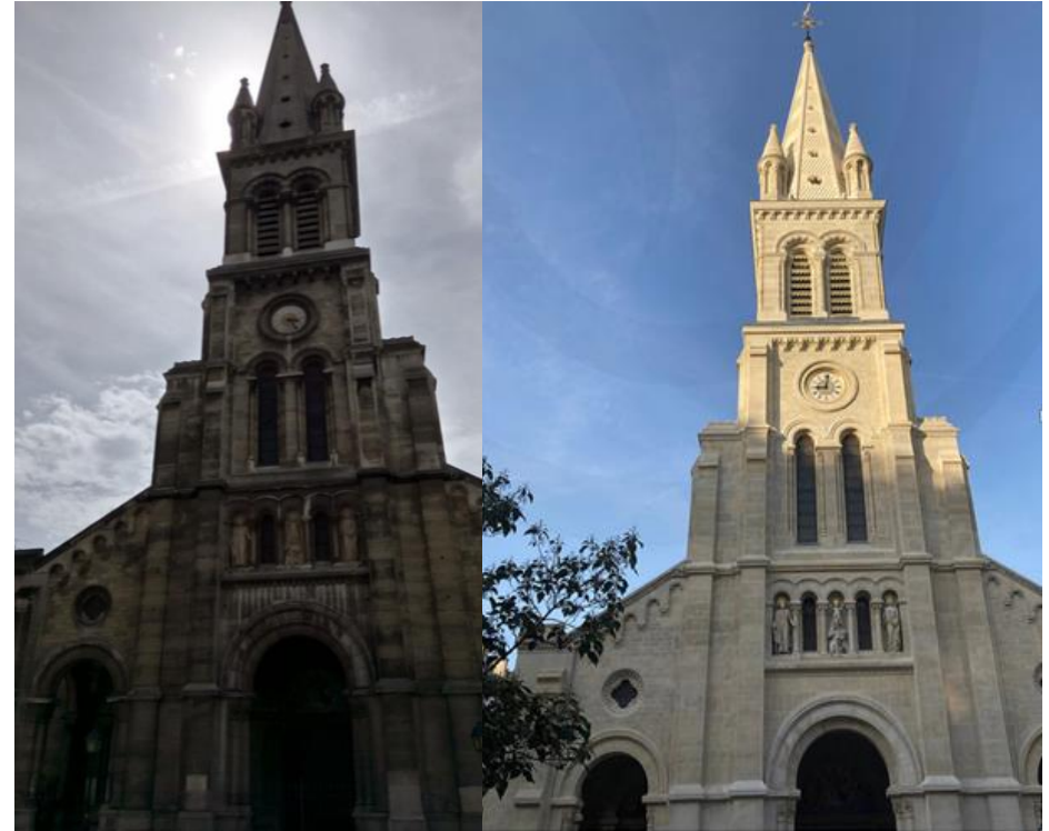
Avant/Après : Le massif d'entrée de l'église Saint-Joseph-des-Nations (11 e )
