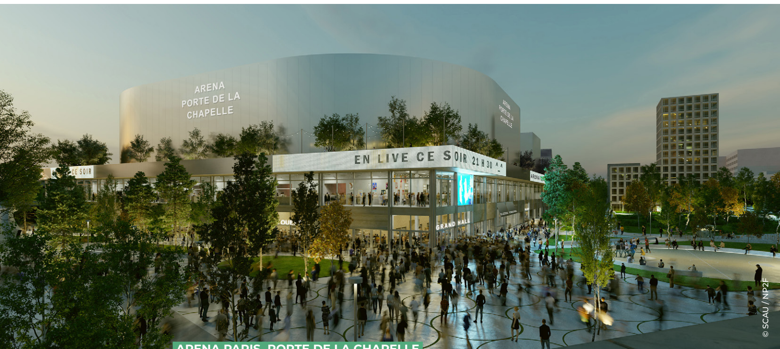
ARENA PARIS, PORTE DE LA CHAPELLE
