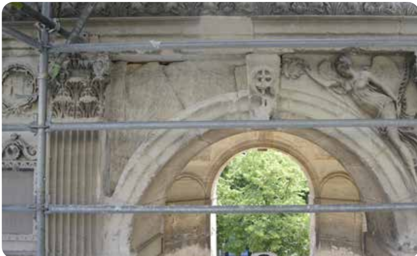
Dépose d'un écoinçon pendant la phase-test © Joseph Guillier/Ville de Paris
